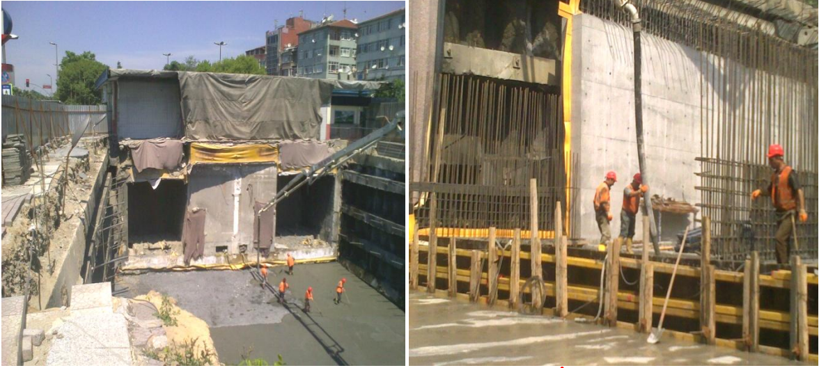
Aksaray Hafif Metro Bağlantısı İnşaatı
