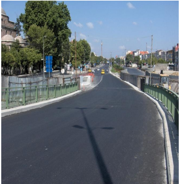
Aksaray Hafif Metro İstasyonu Geri Dolgu ve Asfaltlama alıřmaları
