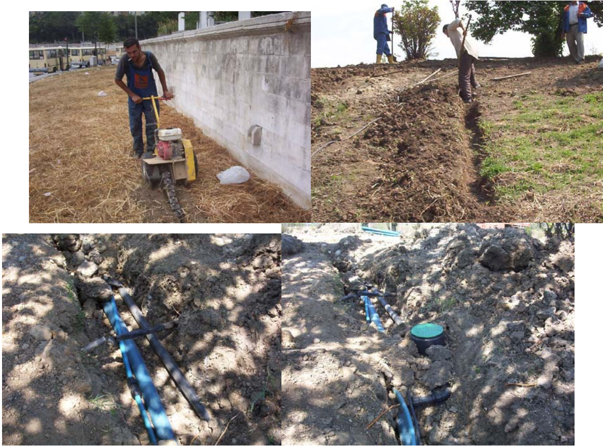
Resim 2 (sulama tesisatı döşenirken)
