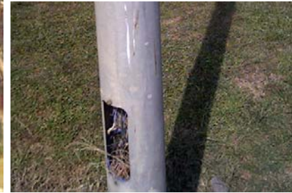
Kırılan ve elektrik donanımı çalınmış aydınlatma elemanları
