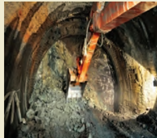
Kısıklı İstasyonu NATM Şaftı ve Tünel Kazı Çalışması, 2012
