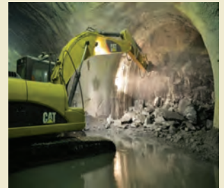
Ümraniye İstasyonu Tünel Kazı Çalışmaları, 2012
