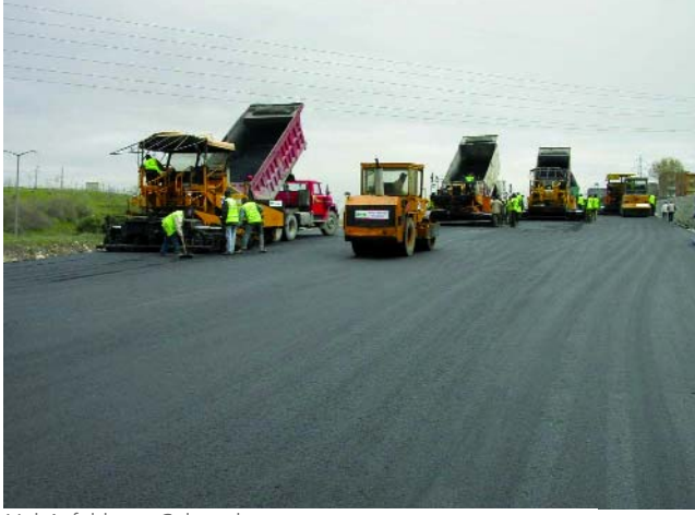
Yol Asfaltlama Çalışmaları
