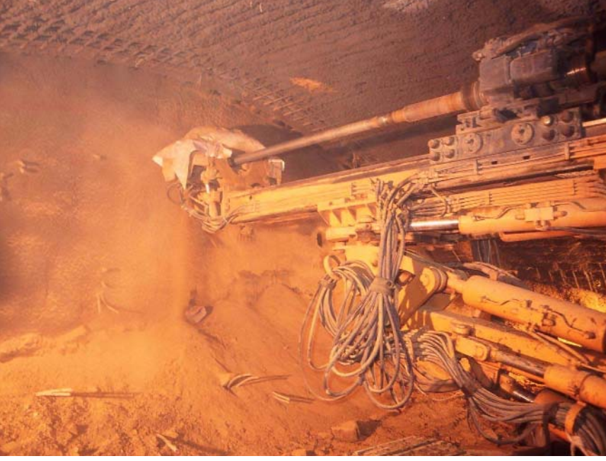
Taksim - Kabataş Füniküler Sistemi Tünel Açma İşlemi
