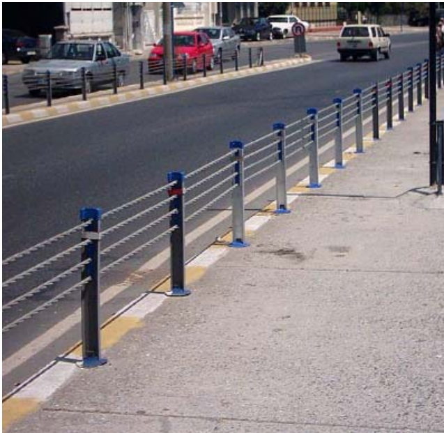
Çelik Halatlı Korkuluk Uygulaması
