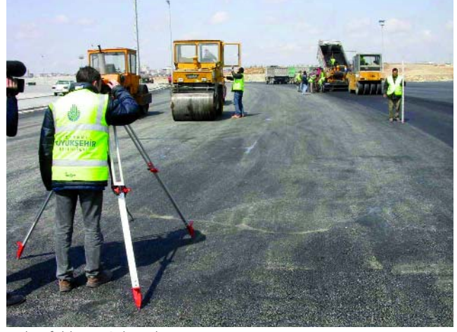
Yol Asfaltlama Çalışmaları
