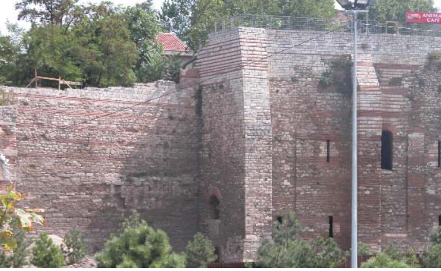
Anemas Zindanları Restorasyon Çalışması
