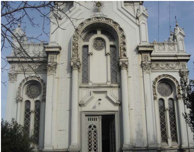
Sveti Stefan Bulgar Kilisesi Restorasyon Çalışması
