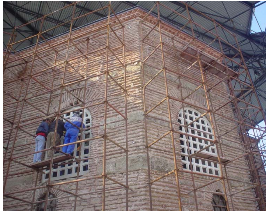
Küçük Ayasofya Camii Restorasyon Çalışması
