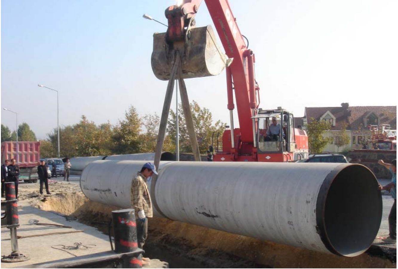
Altınşehir Esenyurt İsale Hattı İnşaatı
