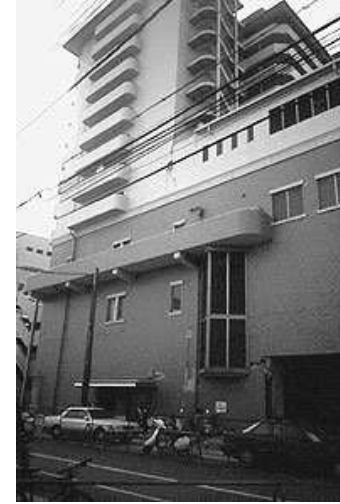
Ashiya yakınlarında bir gökdelenin mesken alanı ile ticari bölümü arasındaki sınırdaki meydana gelen büyük hasar
