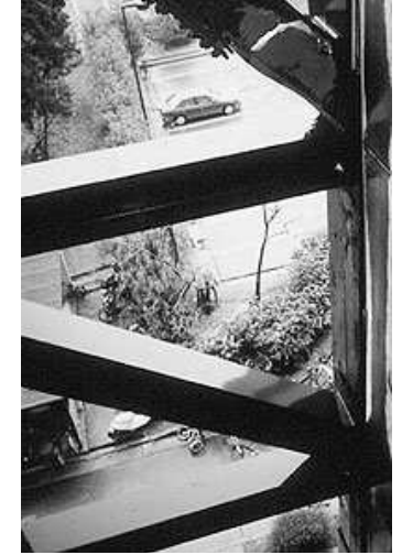
Ashiya, Hama sahil kasabasında bir süper gökdelenin yedinci katı çatlamış çelik çerçeve
