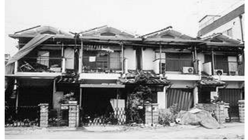
Küçük ölçekli gelişim bölgelerindeki evlerin hepsi duvarlarının depreme dayanıklı olmamasından ötürü tamamen çöktü (Ashiya şehri)
