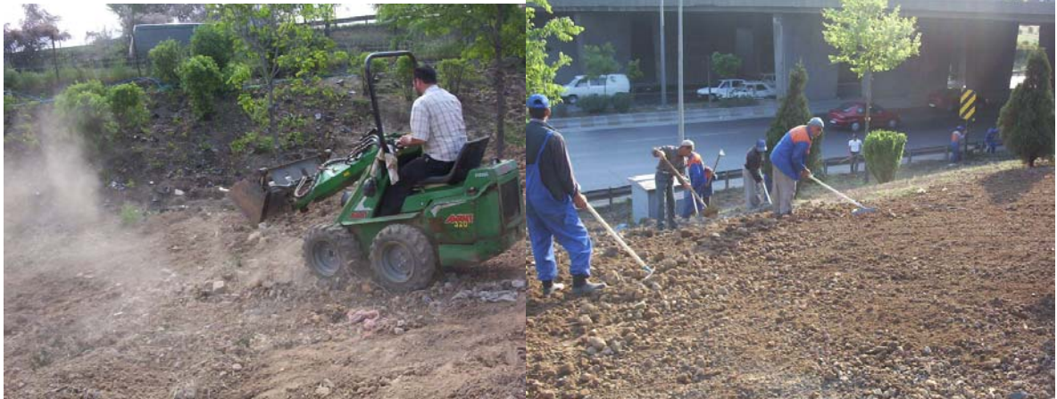
Resim 1 (Alan tesviyesi yapılırken)
