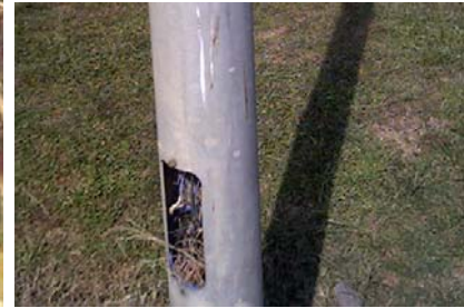
Kırılan ve elektrik donanımı çalınmış aydınlatma elemanları
