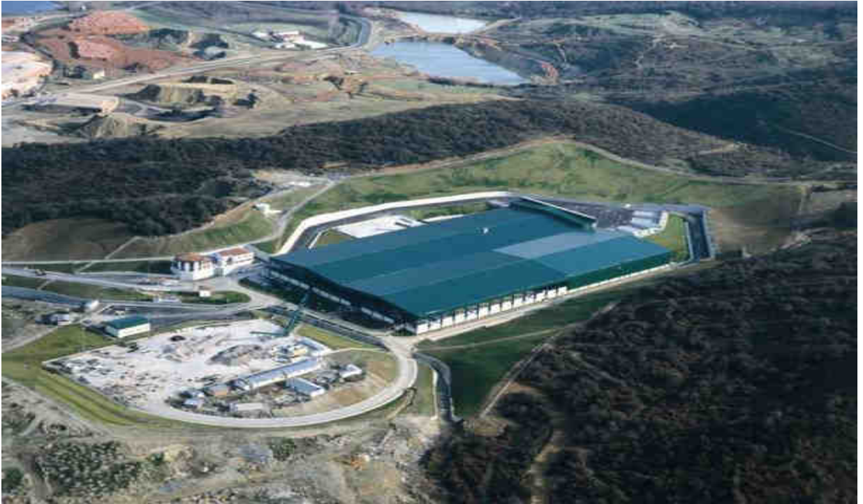
Katı Atık İşleme, Geri Kazanma ve Kompost Tesisi
