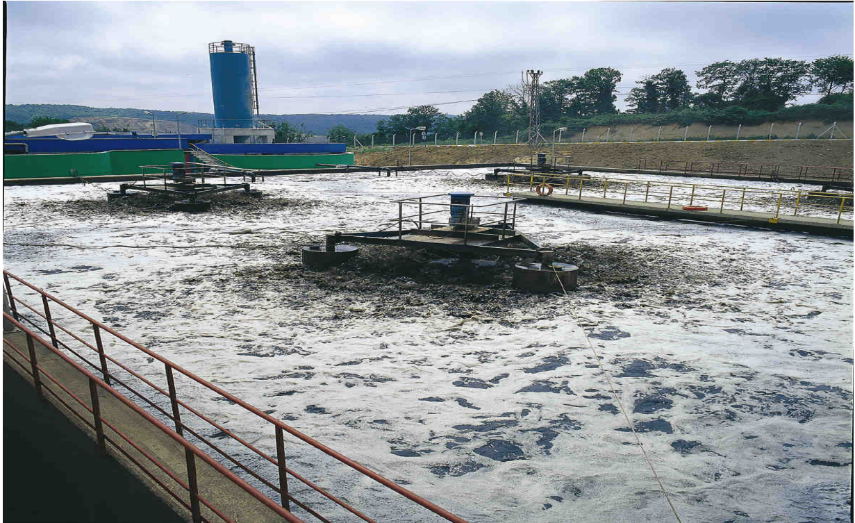
Katı Atık Sızıntı Suyu Arıtma Tesisi
