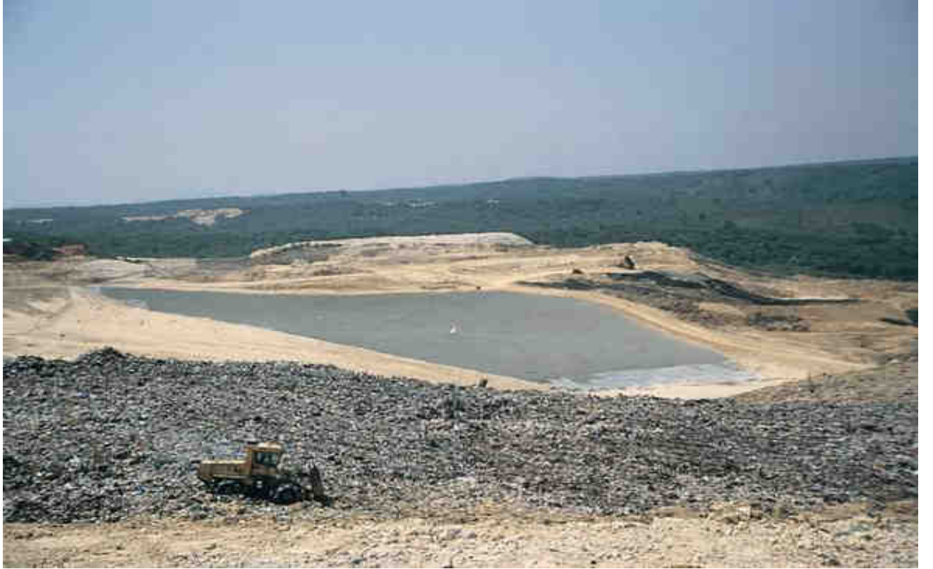
Sızdırmazlık İzolesi Yapılmış Yeni Düzenli Depolama Alanı
